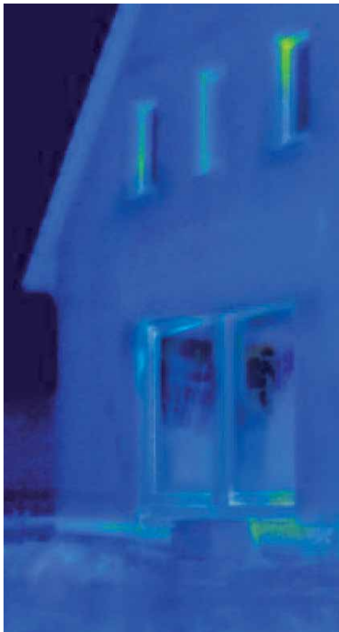
Après rénovation : la mise en œuvre de la porte levante coulissante GENEÓ réduit sensiblement la perte thermique.
